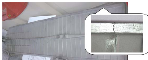
Рис. 12. Термоусталостные трещины на кромке створки
